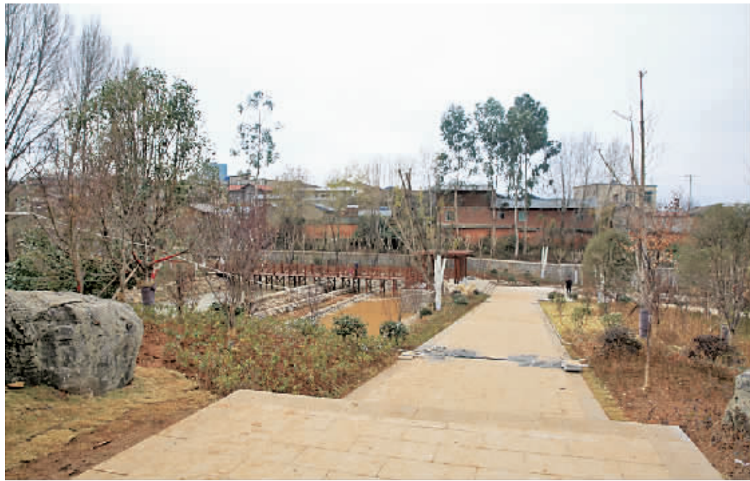
建设中的盐湖公园。
